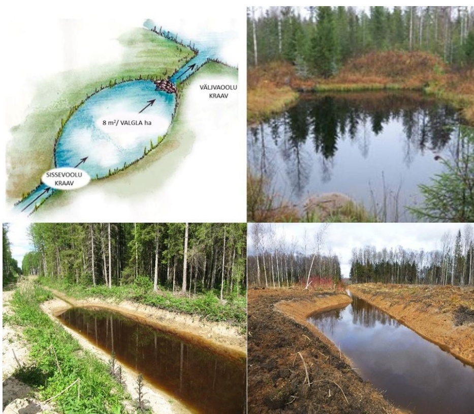
Joonis 12. Settebasseini skeem (kohandatud Finér jt 2018 järgi), foto 20-aastasest settebasseinist Soomes (paremal üleval, Finér jt 2020) ning näiteid settebasseinidest Eestis (all; fotod M. Vaikre ja L. Remm).
