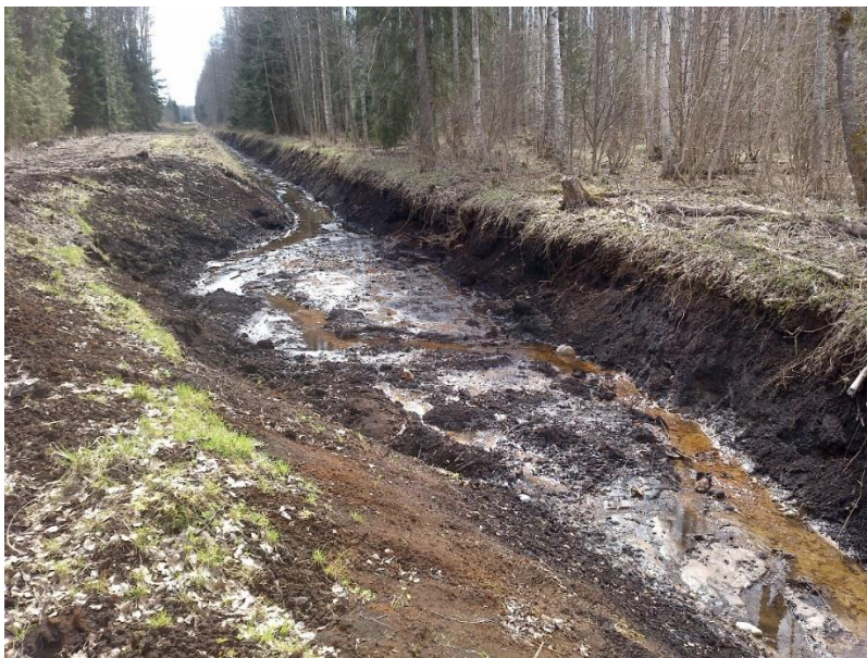
Joonis 21. Ebaõnnestunud kraavilaiend sügaval turbamullal. Foto M. Vaikre.
