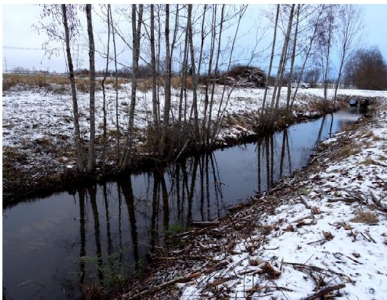
Joonis 10. Jäniõe puhastamisel jäeti osa puudest kraavikaldaile kasvama, mis aitab veekogu temperatuurirežiimi reguleerida ning kaldaid stabiliseerida (Kasak ja Piirimäe 2019).
