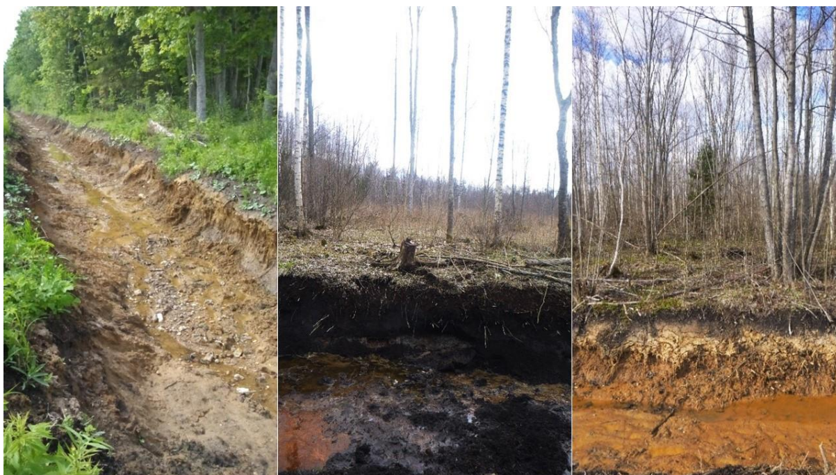
Joonis 3. Nõlvade voolamine hiljuti rekonstrueeritud kraavidel Tartumaal Selgisel. Fotod M. Vaikre ja L. Remm.
