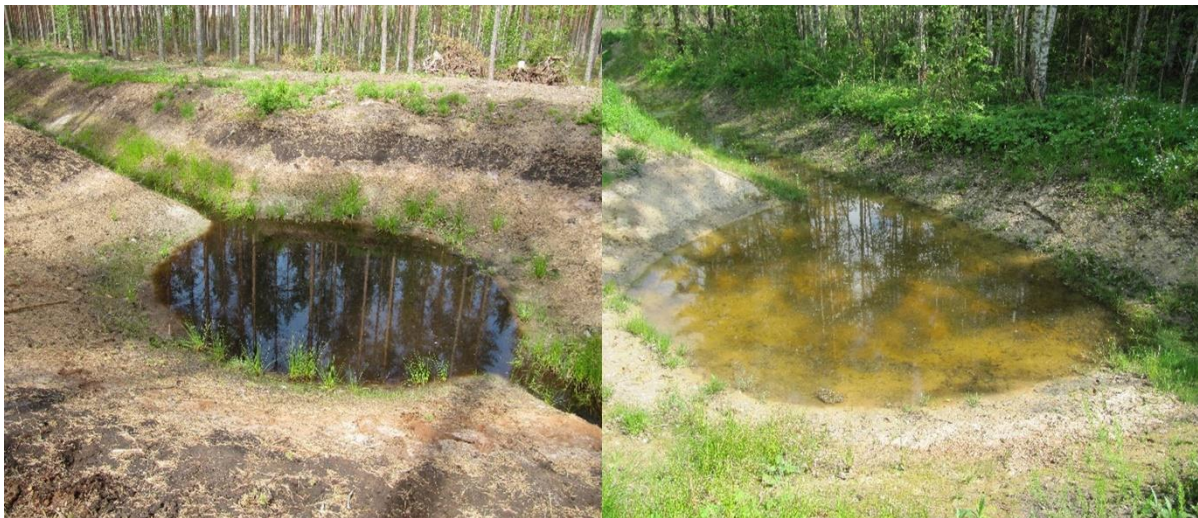
Joonis 20. Kraavide rekonstrueerimise käigus rajatud kraavilaiendid. Fotod M. Vaikre.
