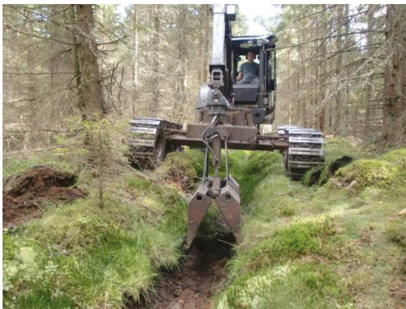
Joonis 18. Kraavipõhja puhastamine spetsiaalse kopaga (Finér jt 2018).
