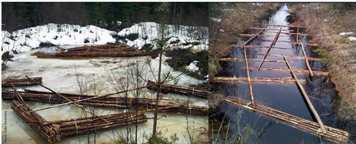
Joonis 19. Näiteid puittõkestitest settebasseinides (Vuori jt 2021).
